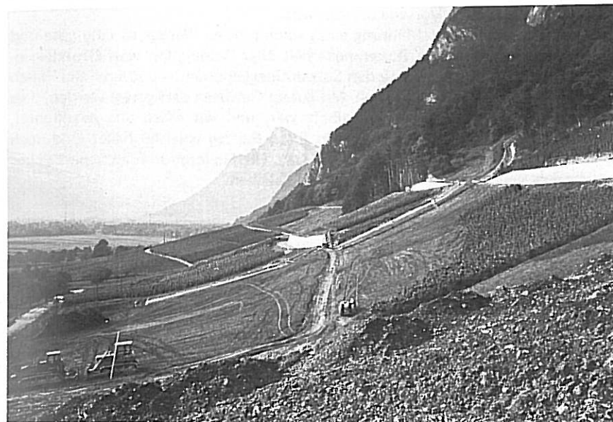
Altes Rebgebiet – Planierung des Geländes und Erschliessung mit Wegen
