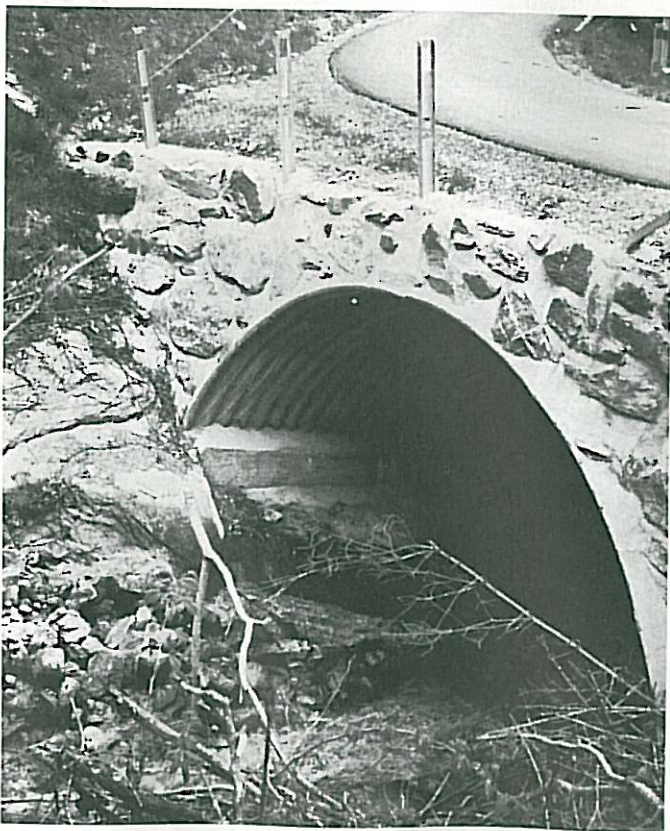
Wellblech als Lehre eines in Beton ausgeführten Überganges
