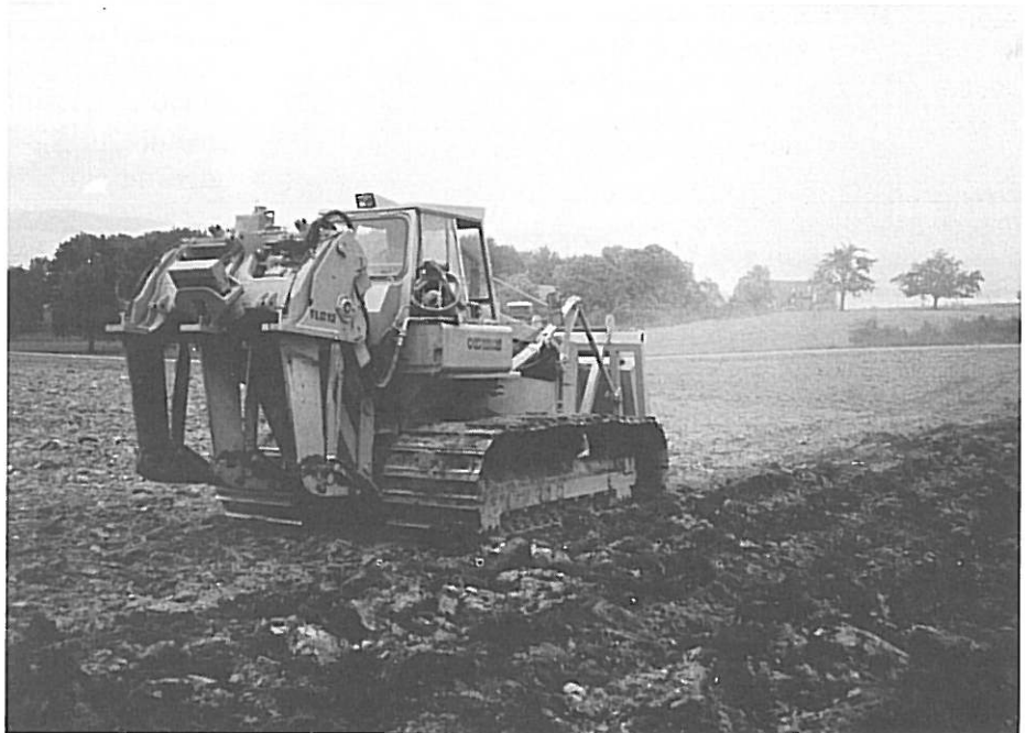
Beispiel einer Bodensanierung: Tieflockerung eines verdichteten Bodens.
