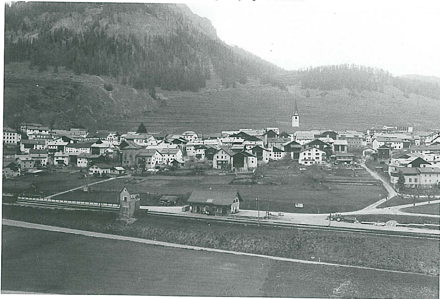
Ardez, Südansicht, in der Bildmitte oberhalb der Station RhB das Quartierplangebiet Chanvers.
