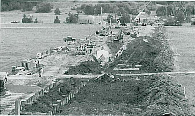
*Die 30 Meter breite Baustelle. Rechts aussen die begrünzte Humusdeponie, anschliessend die Unterbodendeponie. Im Vordergrund sieht man den bereits wieder verfüllten Rohrgraben. Links aussen die mit Baggermatratzen (Holzschwellen) ausgelegte Fahrpiste.*
