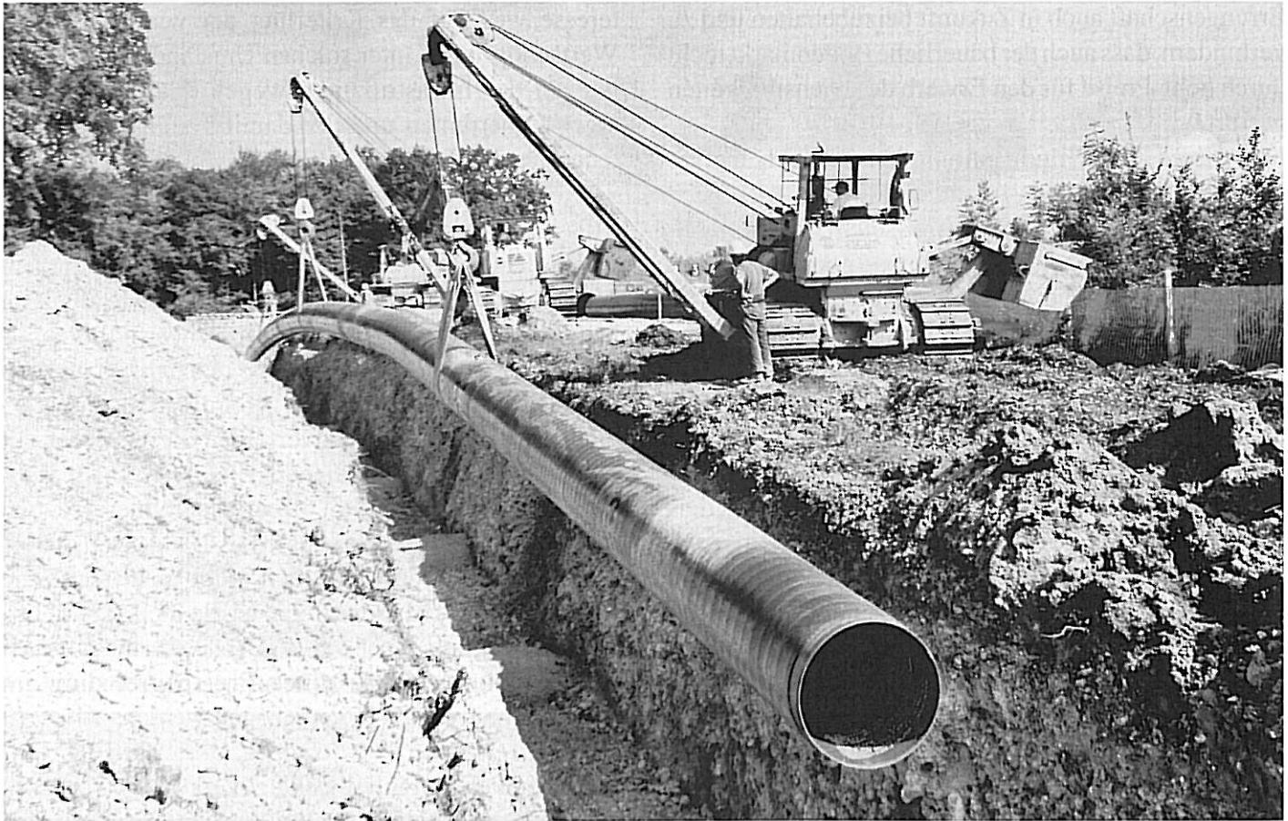
Aufgeschüttete Arbeitspisten zur Lastverteilung gegen die starke mechanische Belastung der Böden während der Rohrabsenkung
