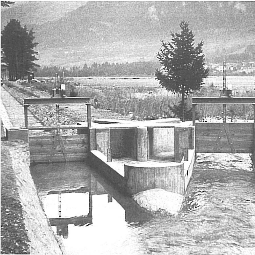
Wässerkanalsystem der Kolmatierung in der Talebene des Domleschg (GR)
